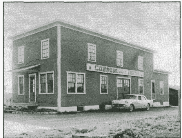
Manufacture construite en 1936
